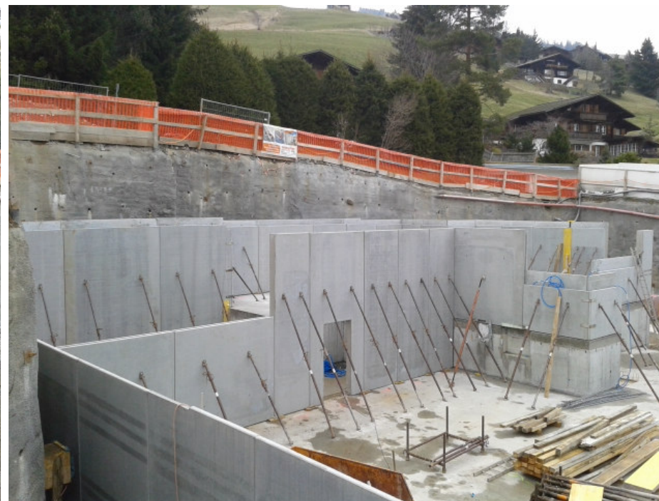
Wände aus Betonelementen
