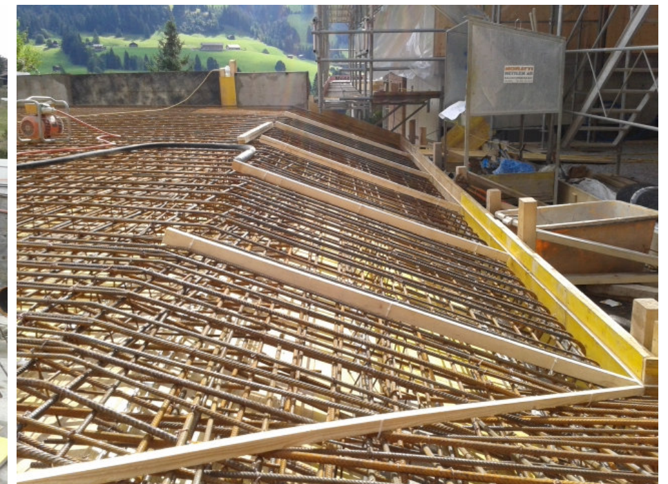
Armierung Decke über Hallenbad
