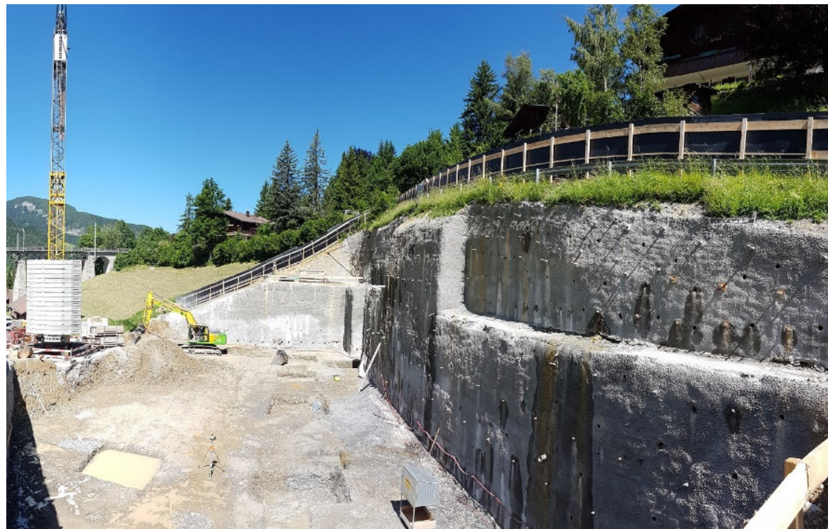
Aushub und Nagelwand
