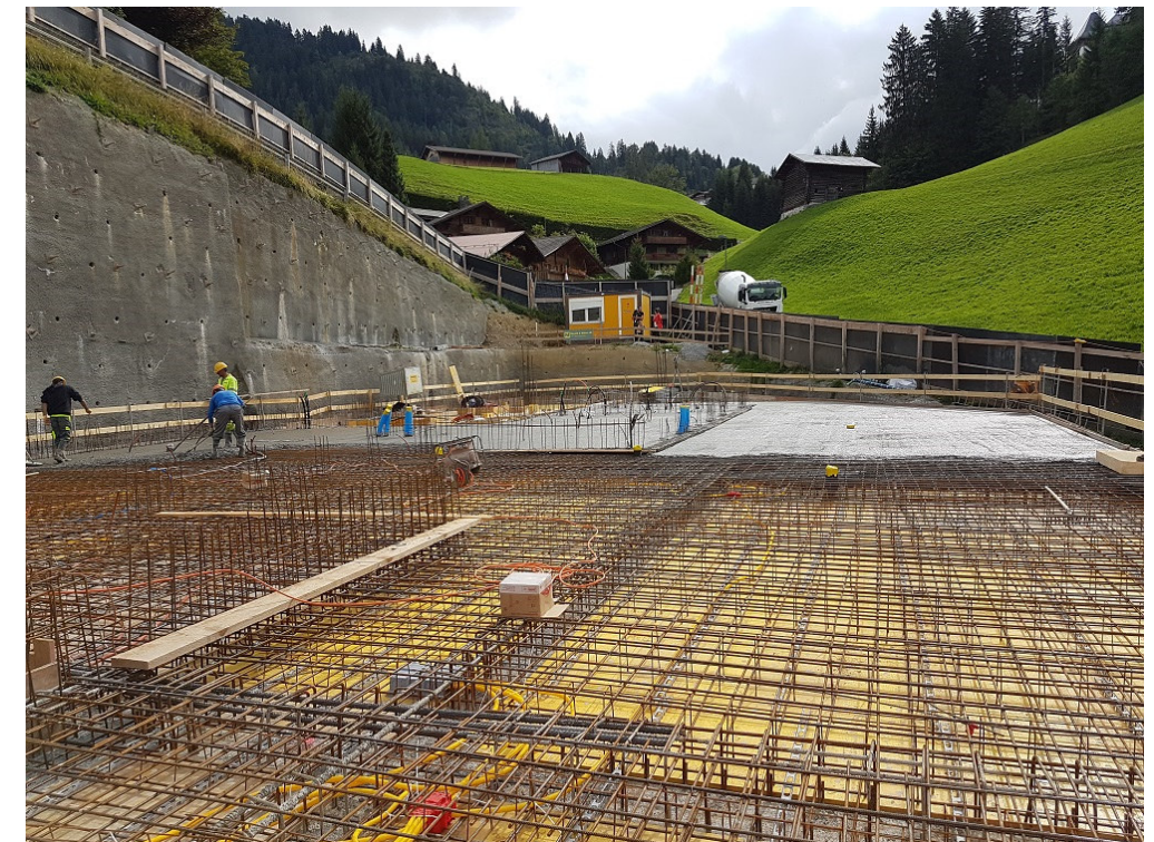
Armierung Decke über Einstellhalle
