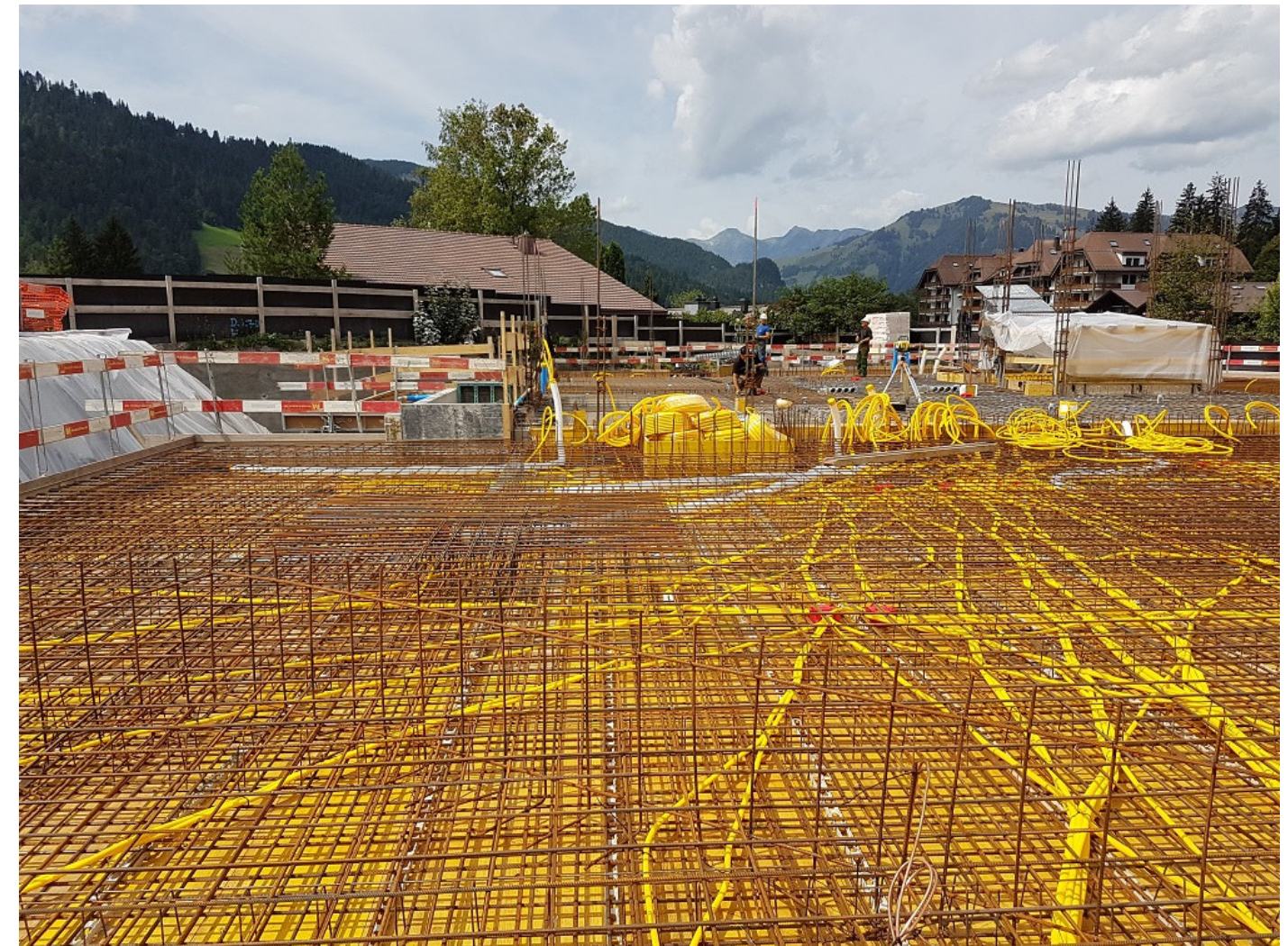
Armierung Decke über 1.Untergeschoss
