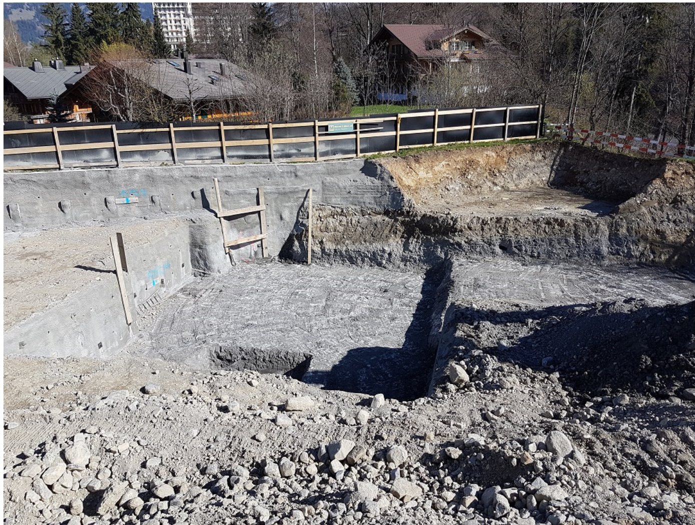
Aushub und Nagelwand
